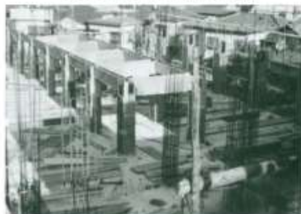
工事中の新校舎
