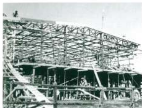
工事中の体育館
