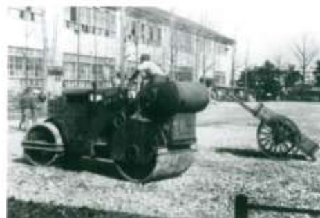
校庭のほそう工事（昭和29年）
